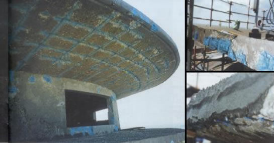
Figura 8. Interventi di protezione delle armature contro la corrosione.
